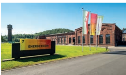
Aus den Tiefen des Erdreichs wird die Wärme fürs Museum gefördert.
