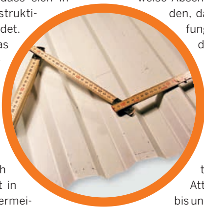
Die Vertiefungen der Bleche können bei der Dämmung von Hallendächern Probleme machen.
