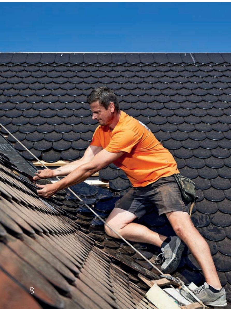
Dachdecker Daniel Sörnitz (Düsseldorf) legt letzte Hand auf einer Baustelle in Düsseldorf-Wersten an: Eine akkurate Bauausführung ist bei der Optimierung der Gebäudehülle unerlässlich
